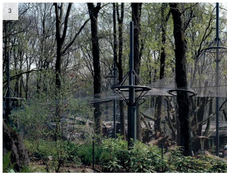
Gehegebau in bestehendem Waldbestand, Baumdurchdringungen im Dachnetz integriert
