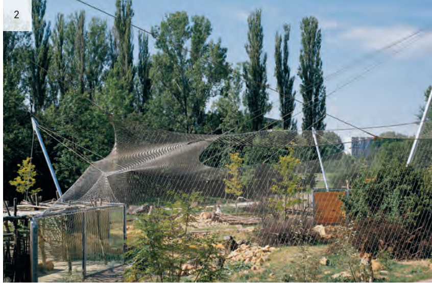
Löwengehege mit von außen spannenden Pylonen Lions enclosure with pylons tensioning from the outside
