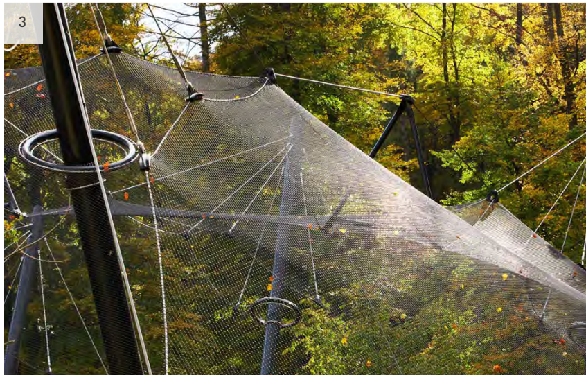
Voliere mit außenliegender Zugseil-Struktur Aviary with exterior tension cable structure
